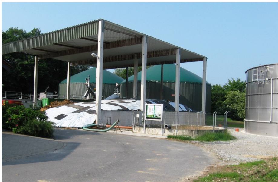
Abbildung VI / 7: Ansicht der Biogasanlage Haus Düsse
