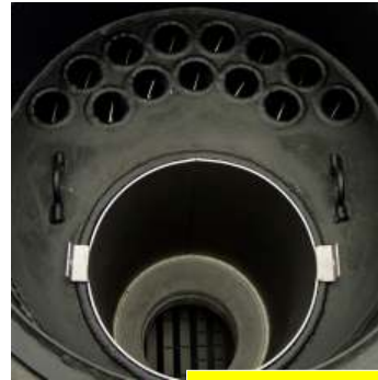
Wärmetauscher
