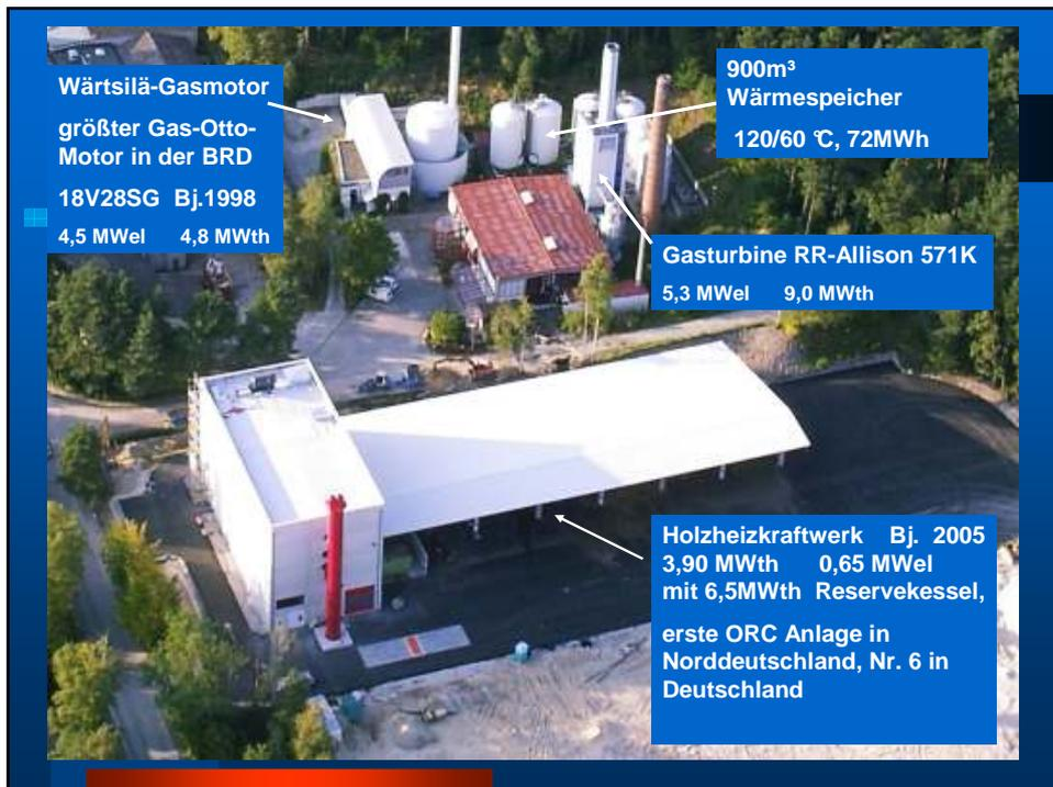
**Organic Rankine Circle: Thermodynamischer Kreisprozess bei niedrigen Drücken (~1 bar) und Temperaturen (< 300°C) mit einem synthetischen Arbeitsmittel (Silikonöl)**
