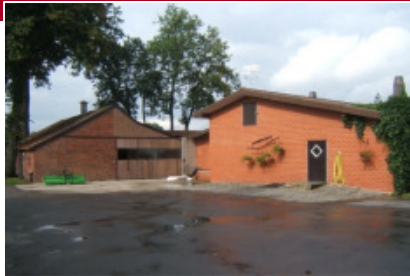
Freren Leistung: 110 kW
