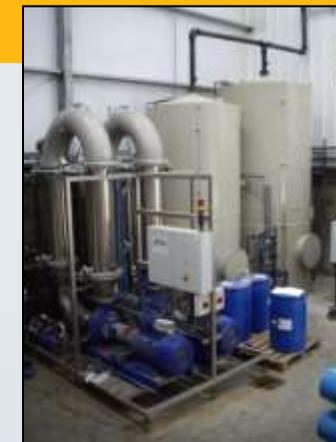
**Beschreibung** Die Gärrestaufbereitung besteht aus den Prozessschritten Fest/ Flüssig Separation, Ultrafiltration und Umkehrosmose. Der Anlagenablauf wird direkt eingeleitet. Das anfallende NK-Konzentrat wird als Düngemittel eingesetzt.
