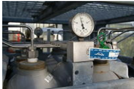
Foto 3: Über den Flaschendruck lässt sich grob die Verbrauch kontrollieren und ermitteln
