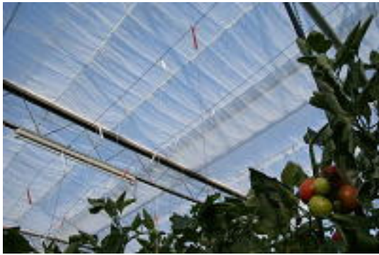
Foto 6: Falls vorhanden sollte das Gewächshausvolumen auch tagsüber durch einen Tageslichtschirm reduziert werden
