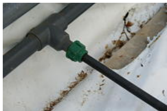
Foto 5: Einfach und praktisch: Verteilung des Ethylens über die vorhandenen CO 2 -Verteilschläuche
