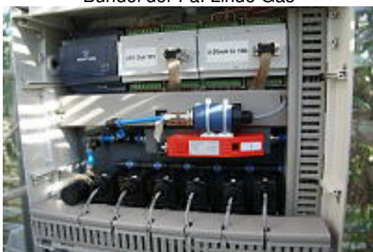
Foto 4: Die eingestellte Ethylen-Konzentration wird exakt durch Regeltechnik der Fa. HTK gewährleistet
