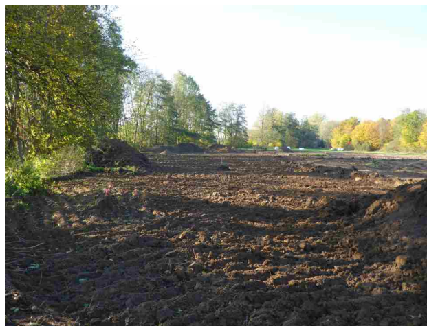
Maßnahmenumsetzung: Oberbodenabtrag im Bereich der Ausbautrasse
