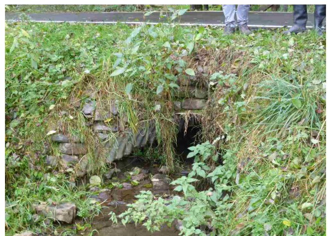
Schollenbach, Wegedurchlass oberhalb der Mündung in die Wupper
