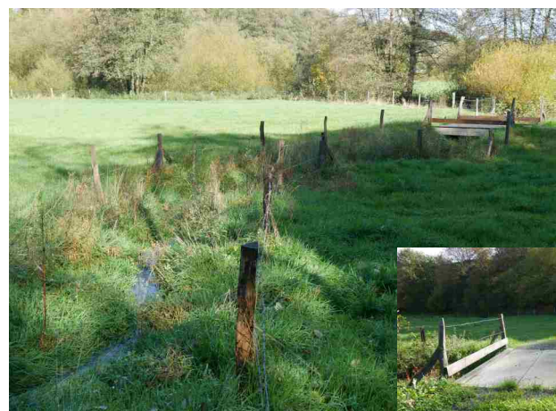
Schollenbach, Situation vor und nach Brückenbau
