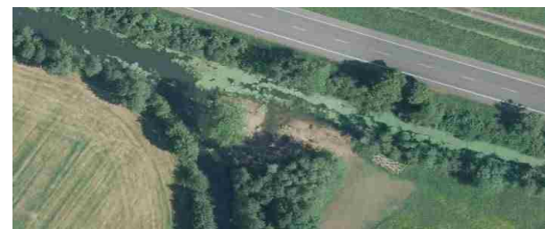
Maßnahme 5: Luftbild vor und nach Umsetzung
