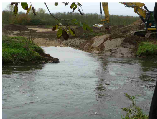
Flutung der neuen Gewässertrasse (November 2013)
