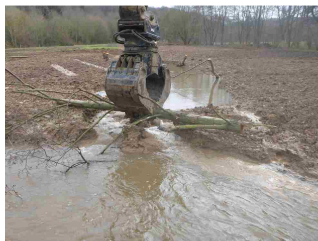
Maßnahmenumsetzung: Einbau von Totholz
