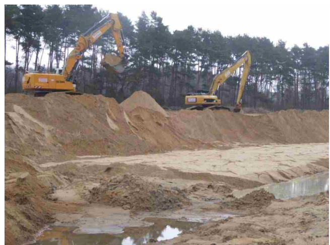
Baggerarbeiten: Modellierung des Neuverlaufs
